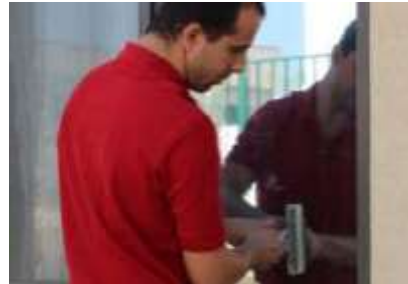
Fase 11: Bagnare nuovamente la superficie della pellicola e premendo con forza con la racla, passare dal centro verso l'esterno fino a quando tutte le bolle d'aria e l'acqua residua non sono stati eliminati dai bordi.
