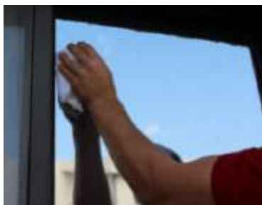
Fase 12: Asciugare i bordi della pellicola e la finestra servendosi di una scheda avvolta in un panno di carta assorbente.
