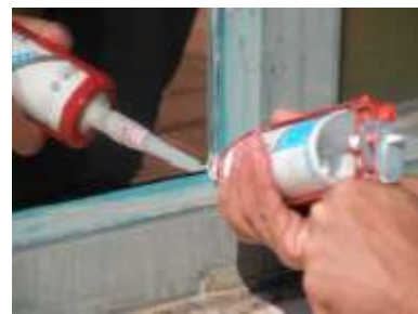
Fase 13: Lasciare che la pellicola si asciughi per 24 ore, quindi entro 72 ore completare l'operazione sigillando i bordi su tutti e quattro i margini.
